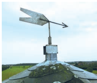
Dach der Mühle
