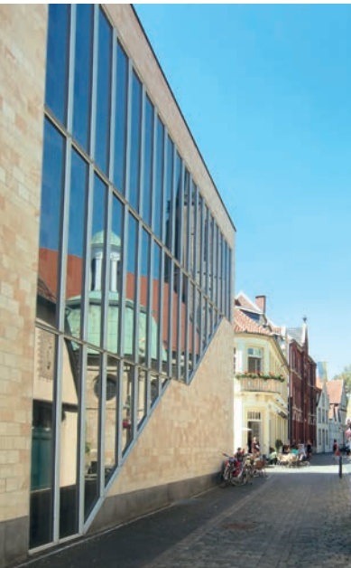
Außenansicht des Neubaus
